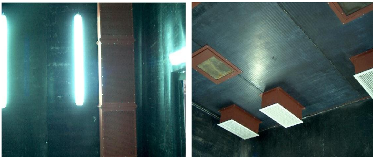
Rys. 4. Izolacja matami gumowymi ścian bocznych (wraz z oświetleniem ściennym i kanałami ssącymi) oraz zabezpieczenie sufitu (wraz z głowicami nawiewowymi).
