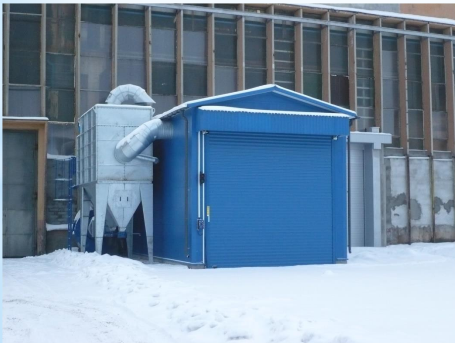
Komora śrutownicza jako obiekt zewnętrzny
